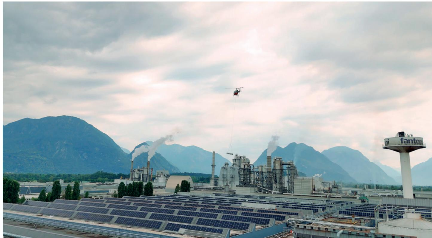
La disposizione dei pannelli sulle coperture piane segue l'andamento est-ovest che ottimizza la potenza installata
