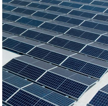
potenza installata mantenendo alta la produttività complessiva. Ogni blocco, di area massima 20 x 20 metri, è stato dimensionato nel pieno rispetto delle nuove Linee Guida VV.FF. DCPREV 14030 del 1° settembre 2025, che introducono fasce di sicurezza più ampie tra i diversi campi fotovoltaici. Tali fasce hanno una duplice funzione:
